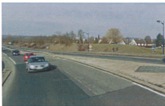
Merlons au carrefour de la RN2 à Soissons
