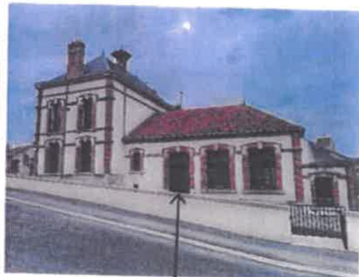
photo entrée PMR
