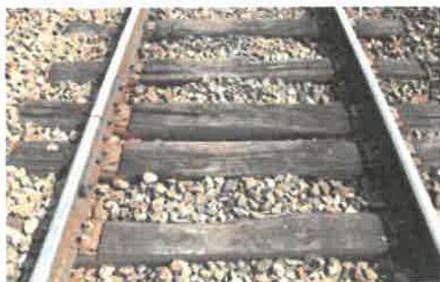
Rails courts sur traverses bois
