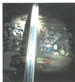
rail après meulage
