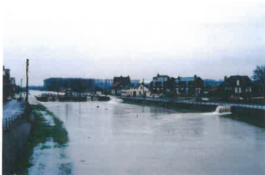
Photographie 11 - L'Oise se déversant dans le canal de Saint-Quentin à Chauny (02) (André Dague, 1993)
