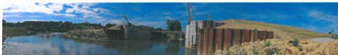
Photographie 14 - Le site d'écrêtement des crues de Proisy
