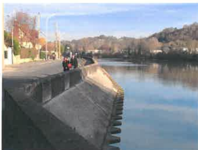
Photographie 17 - Les murets de protection de Creil (60)
