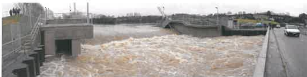
Photographie 8 - Régulation de la crue de janvier 2011 à Proisy (EOA, 2011)
