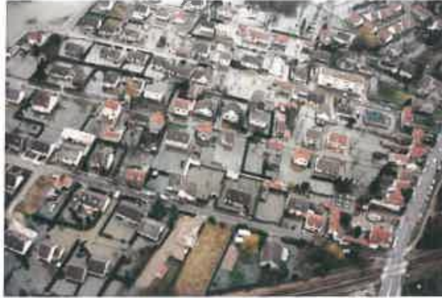
Photographie 7 - Quartier du Marais à Persan (95) lors des inondations de février 1995 (photo d'archive)
