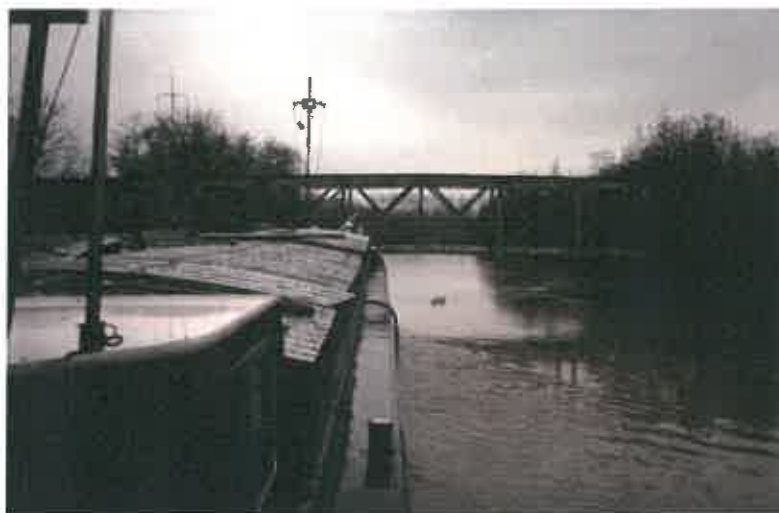
Photographie 10 - Arrêt de la navigation fluviale lors de la crue de 1993 (C. JAUNET, 1993)
