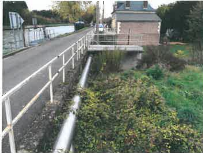
Photographie 18 - Canal latéral à l'Oise et système de vannage à Thourotte (60)
