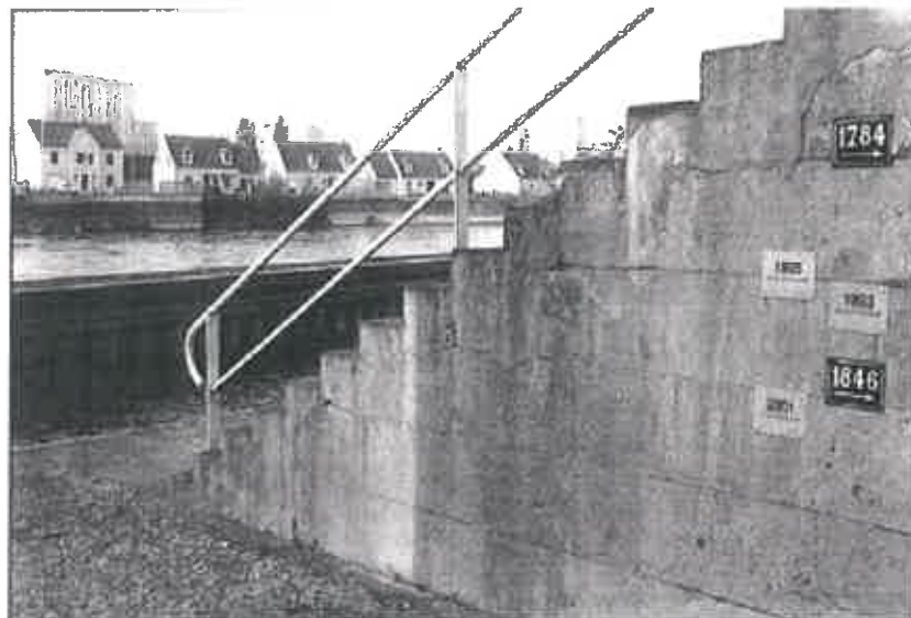
Photographie 4 - Repères de crues de l'écluse de Venette (60) (EPRI, 2011)
