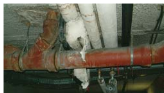
Calorifugeage
