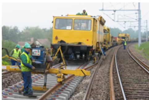
Longs rails soudés sur traverses béton
