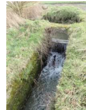
Vue aval OH1
