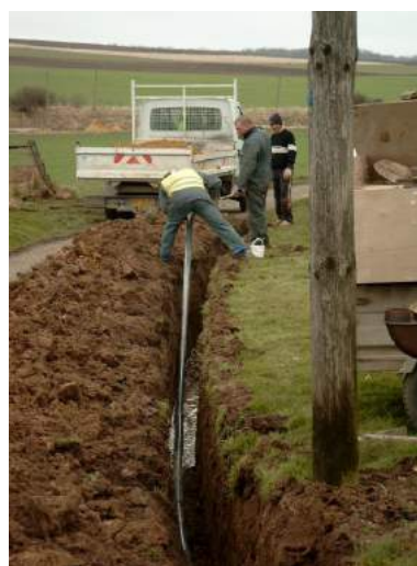
Figure 12 : Réseau d'eau potable
