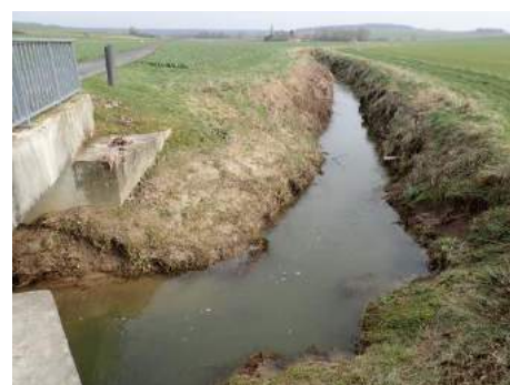
L'Ourcq au droit du pont de la D809
