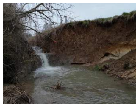
Zone d'érosion résultant de l'ancien ouvrage de décharge de l'Ourcq
