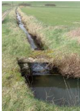
Vue amont OH1
