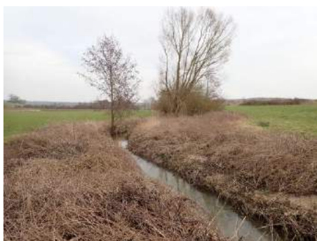
Dépôts de sables sur les berges
