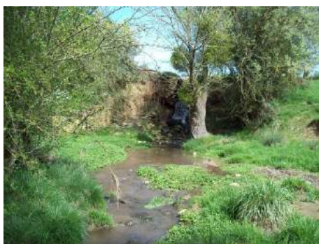
Ouvrage de décharge de l'Ourcq
