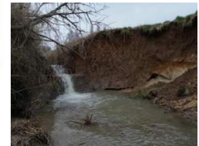
Vue aval chute/érosion
