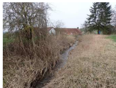
Bief en amont de l'ancien ouvrage de décharge
