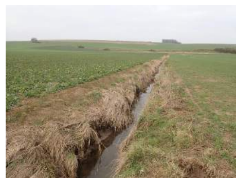
Bras de décharge sur sa partie aval
