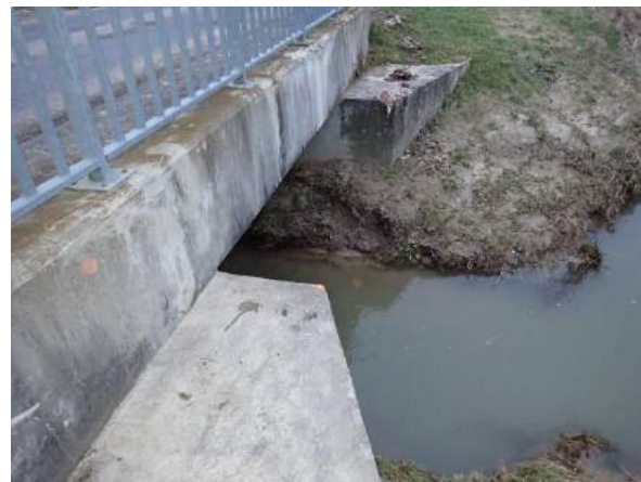
Vue du pont D809
