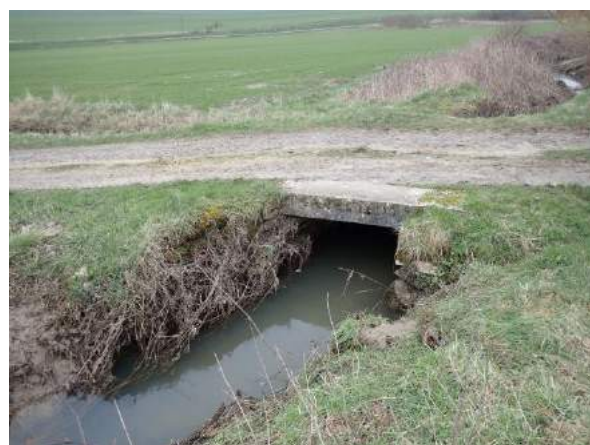
Vue du pont du Ru de Coupé
