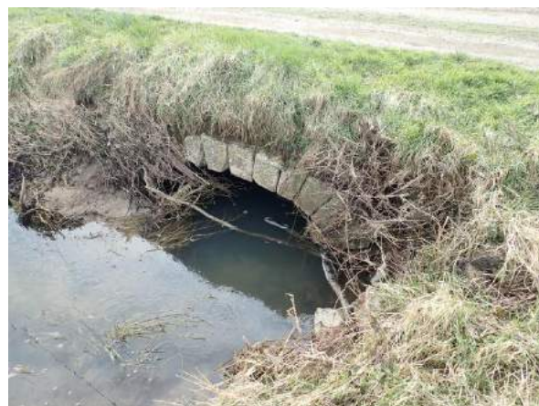
Vue du pont fossé de décharge du Ru de Coupé
