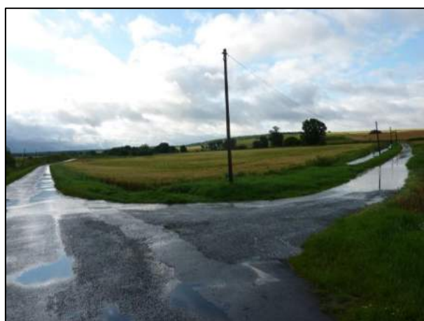
Figure 10 : Entrée vers la zone de travaux par le chemin de Caranda
