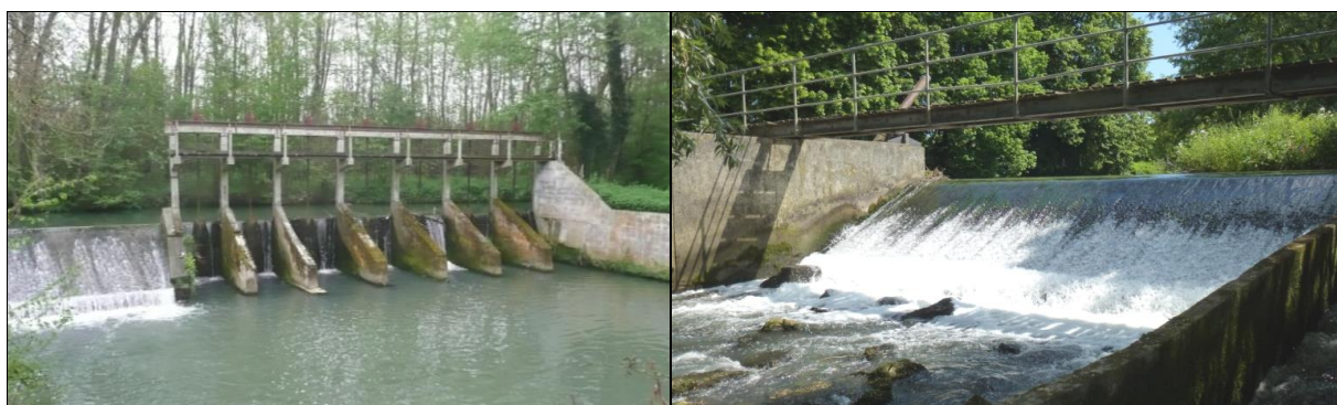
Figure 16: Ouvrages hydrauliques. A gauche : Vannage de Montblin à la Ferté-Gaucher ; A droite : Ouvrage de la coutellerie à Mouroux (Source : SIVHM)
