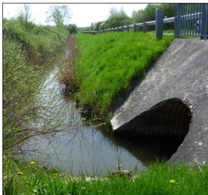
Figure 18: Réalignement de cours d'eau (Site des marais de Saint-Gond)
