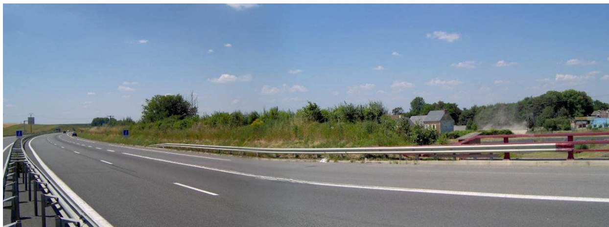
Merlon aux abords de la RN2 à hauteur du diffuseur des RD 23 et 53 (commune de Margival)
