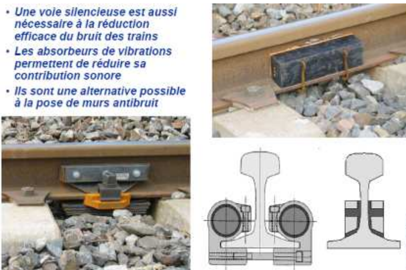
Absorbeur de vibrations sur rail (source SNCF)
