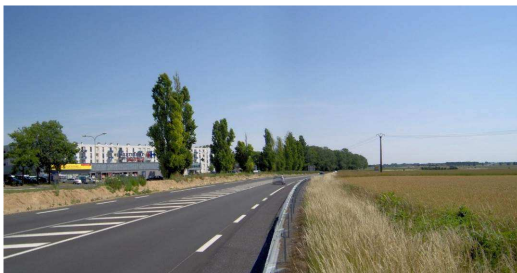
Merlon aux abords de la RN2 à hauteur de la rue du docteur Menu et de la rue Lavoisier (commune de Laon)
